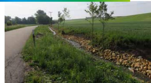
Die Renaturierung des Mühlbaches und einiger Entwässerungsgräben im Osten und Westen von Pfofeld ist abgeschlossen. Das Bachbett wurde 2017 mit Flussbausteinen ausgebaut und Bäume und Sträucher entlang der Böschungen gepflanzt.
