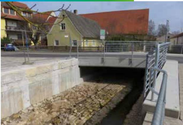
Im Zuge des Brückenbaus wurde das Bachbett darunter mit Flussbausteinen neu angelegt. Eine komplette Renaturierung des Dorfbaches innerorts ist leider nicht möglich, da der Schmutzwasserkanal nur wenige Zentimeter unter dem Bachbett verläuft und bei einem Hochwasser freigeschwemmt werden könnte.
